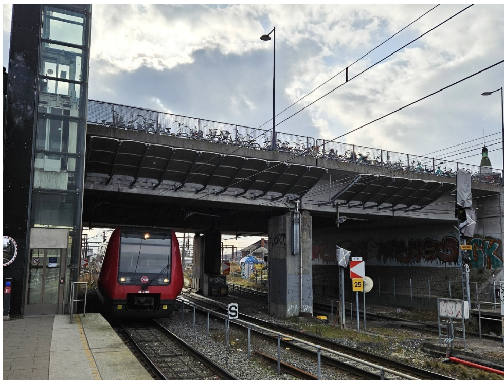
Figur 18-20 Eksempel på skærmtag ved Dybbølsbro Station, hvor Dybbølsbro føres over S-banen (Banedanmark, 2025). Skærmtaget forhindrer, at objekter eller personer falder ned på sporene eller rammer køreledningerne fra vejen.
